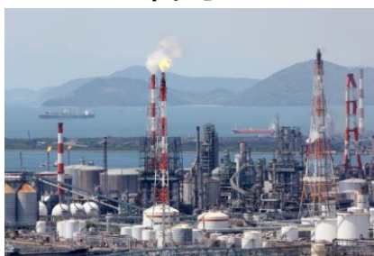
製油所・発電所 89.3百万トン
